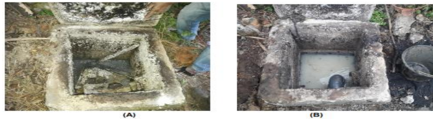
Gambar 5. (A) Bak Kontrol Sebelum Perlakuan (B)Bak Kontrol setelah perlakuan Pengolahan Limbah Cair Tahu dengan Metoda Fotodegradasi
